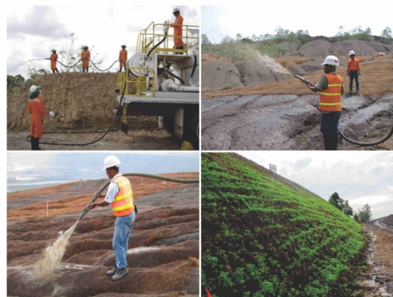
Gambar 4. metode penanaman dengan sistem hidroseeding dengan dikombinasikan mempergunakan cocomesor (PT Unitek Borneo)
