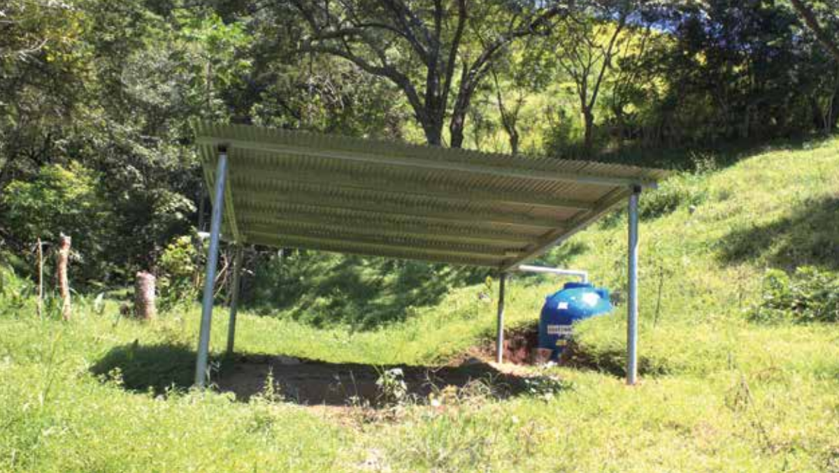
Sistema de cosecha de agua de lluvia que consta de una galera o techo inclinado, una tubería, y un tanque plástico de almacenamiento.
