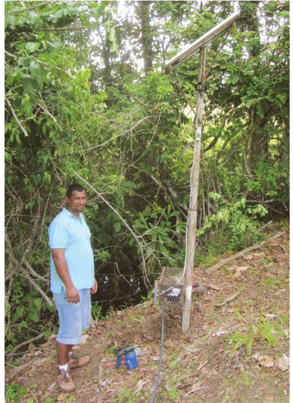
Las bombas de energía solar son económicas y efectivas, pero deben colocarse correctamente y mantenerse alejadas de la sombra para que la luz solar directa llegue al panel solar durante todo el día.
