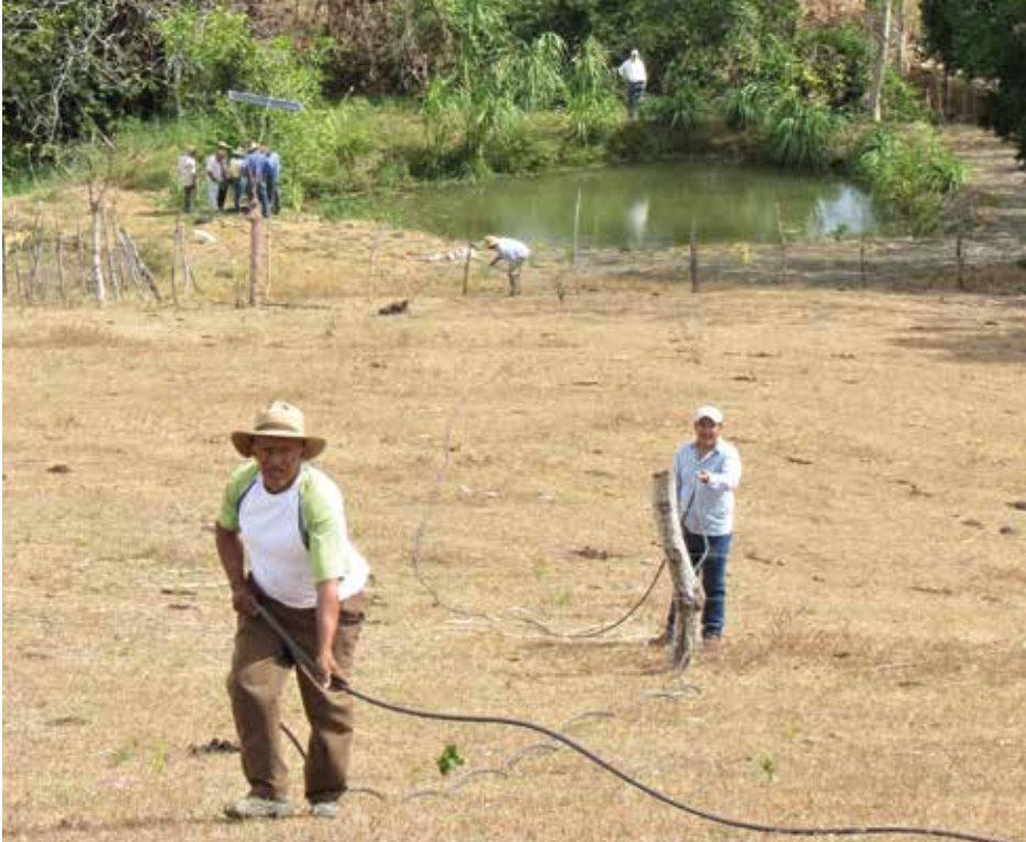
Instalación de la tubería que permite bombear el agua desde el abrevadero en la parte baja de la finca hasta el tanque de reserva ubicado en la parte más alta.
