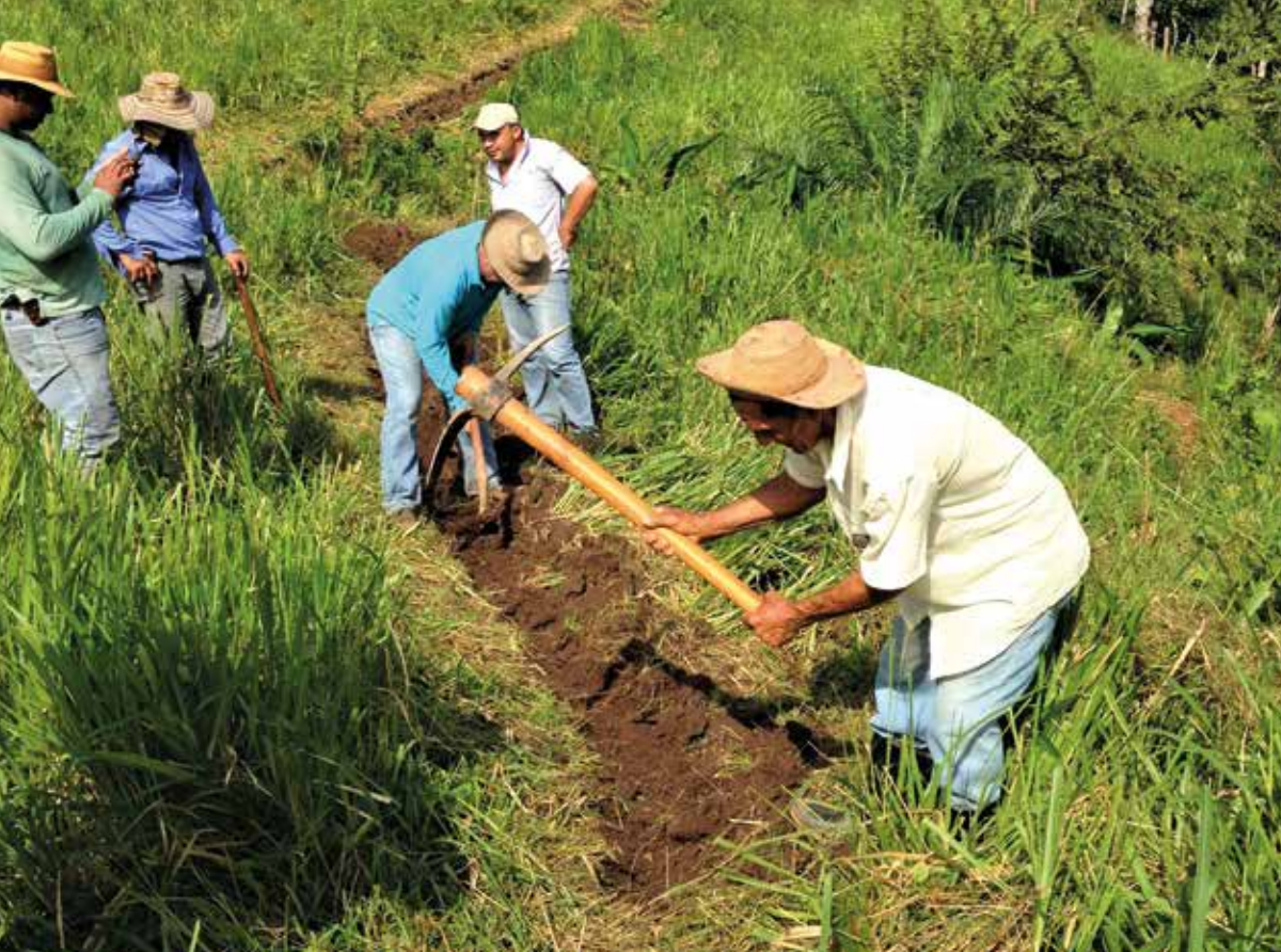
Enterrar las tuberías de agua requiere mucha mano de obra, pero es importante para evitar daños al sistema de agua.
